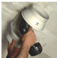
Przymocowanie wspornika
