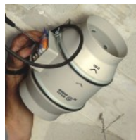
Przyłączenie przewodów zasilania
